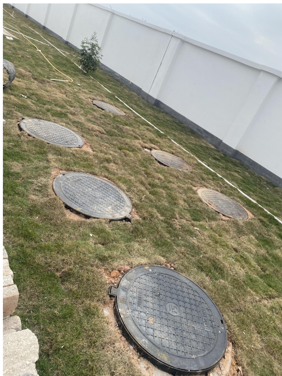
图1 三级化粪池、隔油隔渣池（约 20m 3 ）
